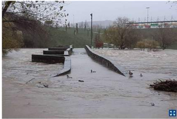
270/302 Puente de Burlada.
