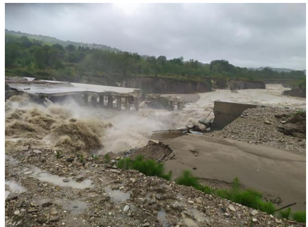
Figure 10. A bridge collapsed in Verucchio, near Rimini. Credit: Comune di Verucchio/Facebook.
